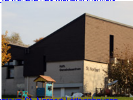
Katholisches Gemeindezentrum St. Norbert Löttringhausen
